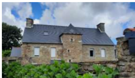
Toiture du presbytère
