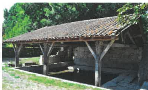
Couverture en bac acier aspect tuiles
